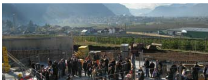
Il cantiere dove sorgeranno i due edifici per un totale di 24 appartamenti. Die Baustelle, wo sich die zwei Gebäude mit insgesamt 24 Wohnungen erheben werden.
